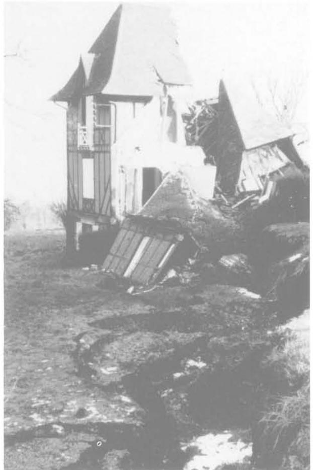
Fig. 4. — Glissement de terrain à Villerville. (cliché B.R.G.M.).
