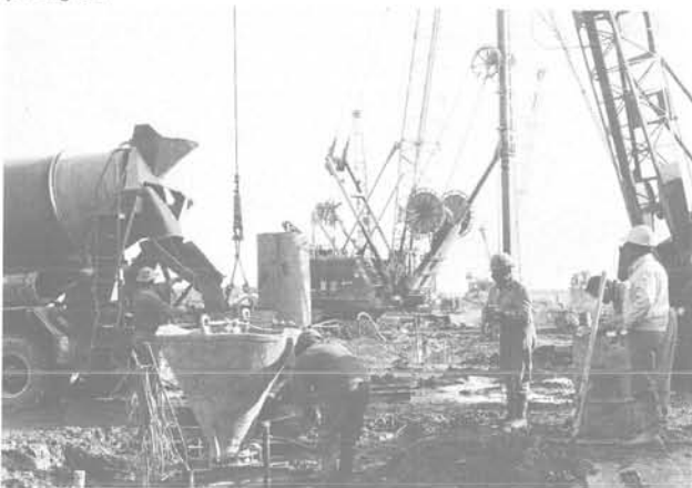
Cliché n° 7 Bétonnage d'un panneau de voûte au tube plongeur
