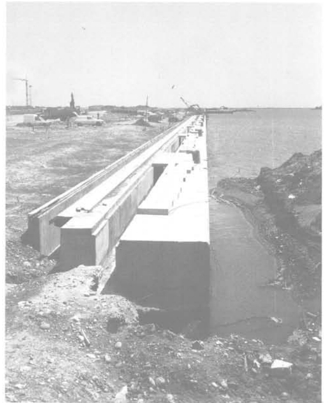
Cliché n° 10 Vue du quai depuis l'extrémité N.O.
