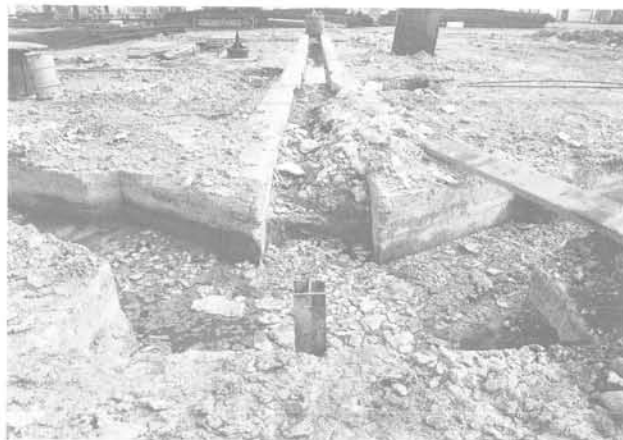
Cliché n° 2 Présaignée à l'emplacement de la pièce de tête et d'un tirant plan
