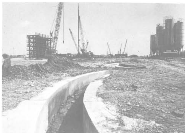
Cliché n° 3 Présaignée à l'emplacement des voûtes
