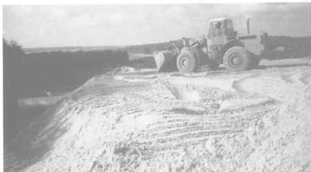
Fig. 5(a). — Remblaiement des buses terminé.
