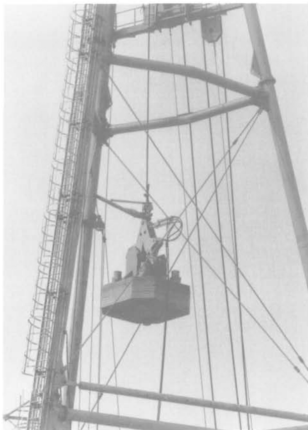
Fig. 10. — Vue partielle du tripode permettant de détailler le pilon retenu par sa pince hydraulique pendant son levage.
