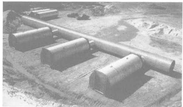
Fig. 3. — Montage des buses avant remblaiement.
