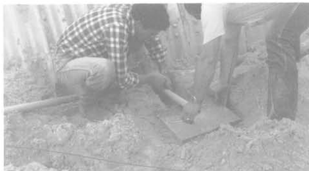
Fig. 5(b). — Mesures de déplacements horizontaux: plot de béton et tube de P.V.C
