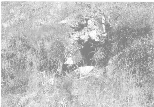
FIG. 5 Photographie d'un chenal à l'affleurement. Photography of a drainage channel on a till outcrop.
