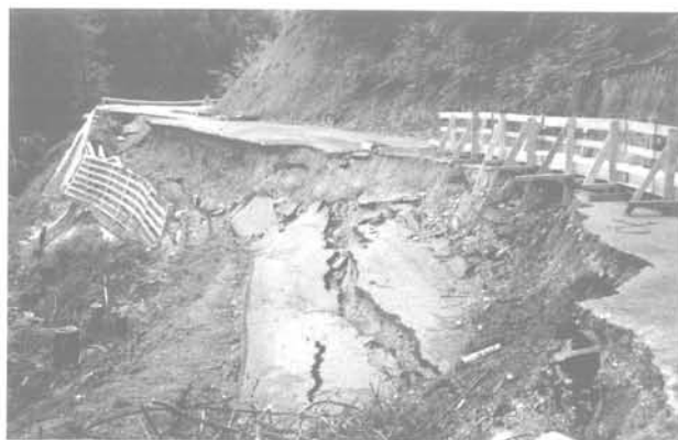
FIG. 7A État avant les travaux (photo : Bureau Maric). Before road works.
