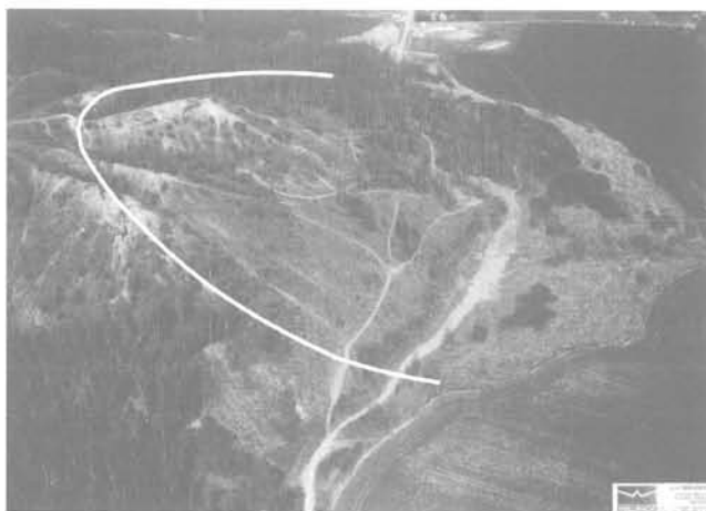
FIG. 18 Glissement Est : avancée du bourrelet de pied, escarpement de tête. East slide : toe-head scarp.
