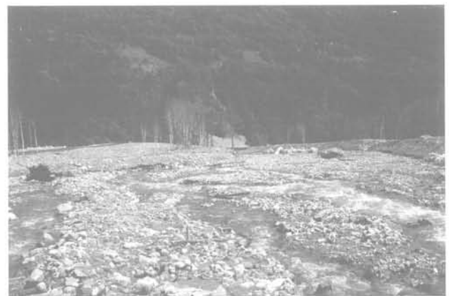
FIG. 7 Plage de dépôt (en partie artificielle) de l'Arbonne. Vue vers l'aval (voie ferrée sur la gauche), cote 850-800. Deposition area of the Arbonne torrent. Downstream view (railway track on the left), elevation 850-800.
