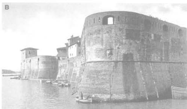
FIG. 6 L'examen de sources historiques permet de détecter l'aggravation des affaissements sur le long terme. a) L'antique forteresse dite Mastio di Mathilde , à Livourne, du X e siècle, agrandie par A. da Sangallo, comme elle apparaît de nos jours ( Rassegna dei Beni Culturali , 4, 1990). b) Le même monument comme il apparaissait sur une photo de 1935 (tiré du volume Toscana , TCI, 1935). The long-term progress of settlements can be discovered by inspecting historical evidence: a) The old Fortress « Mastio di Matilde », in Leghorn dated X century, enlarged by A. da Sangallo, as it appears today ( Rassegna dei Beni Culturali , 4, 1990); b) The same monuments in a picture of 1935 (from Vol. Toscana , TCI, 1935).
