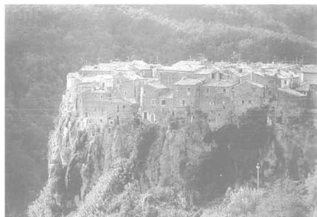
FIG. 5 Les fondations (F) et les structures (S) doivent être considérées comme partie intégrante de l'assise rocheuse (T), dont bien souvent elles ne se distinguent pas. L'illustration représente la petite ville de Calcata, dans le Latium.
